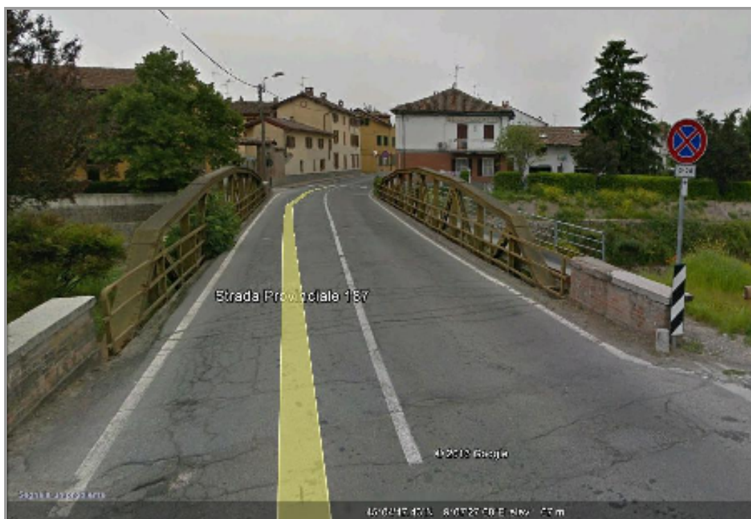
Figura 11 – Ponte sul Coppa nel centro abitato di Bressana Bottarone (immagine Google map)
