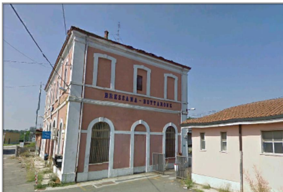
Figura 5 Stazione ferroviaria di Bressana Bottarone nella zona occidentale del comprensorio comunale in centro paese
